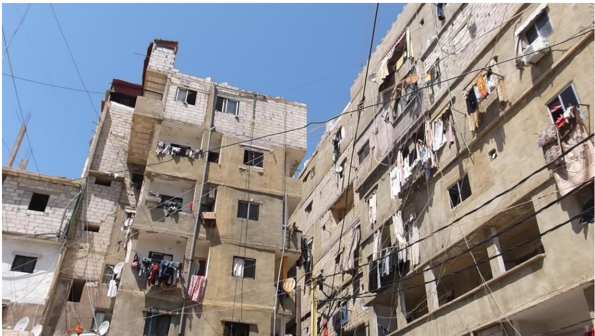
Immeubles à Chatila
